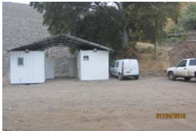
Instalación de faenas de Topografía y Prevención de Riesgos al pie del Muro Principal
